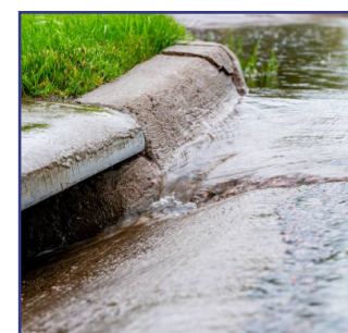
DRENAJE DE AGUA
