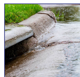
DRENAJE DE AGUA
